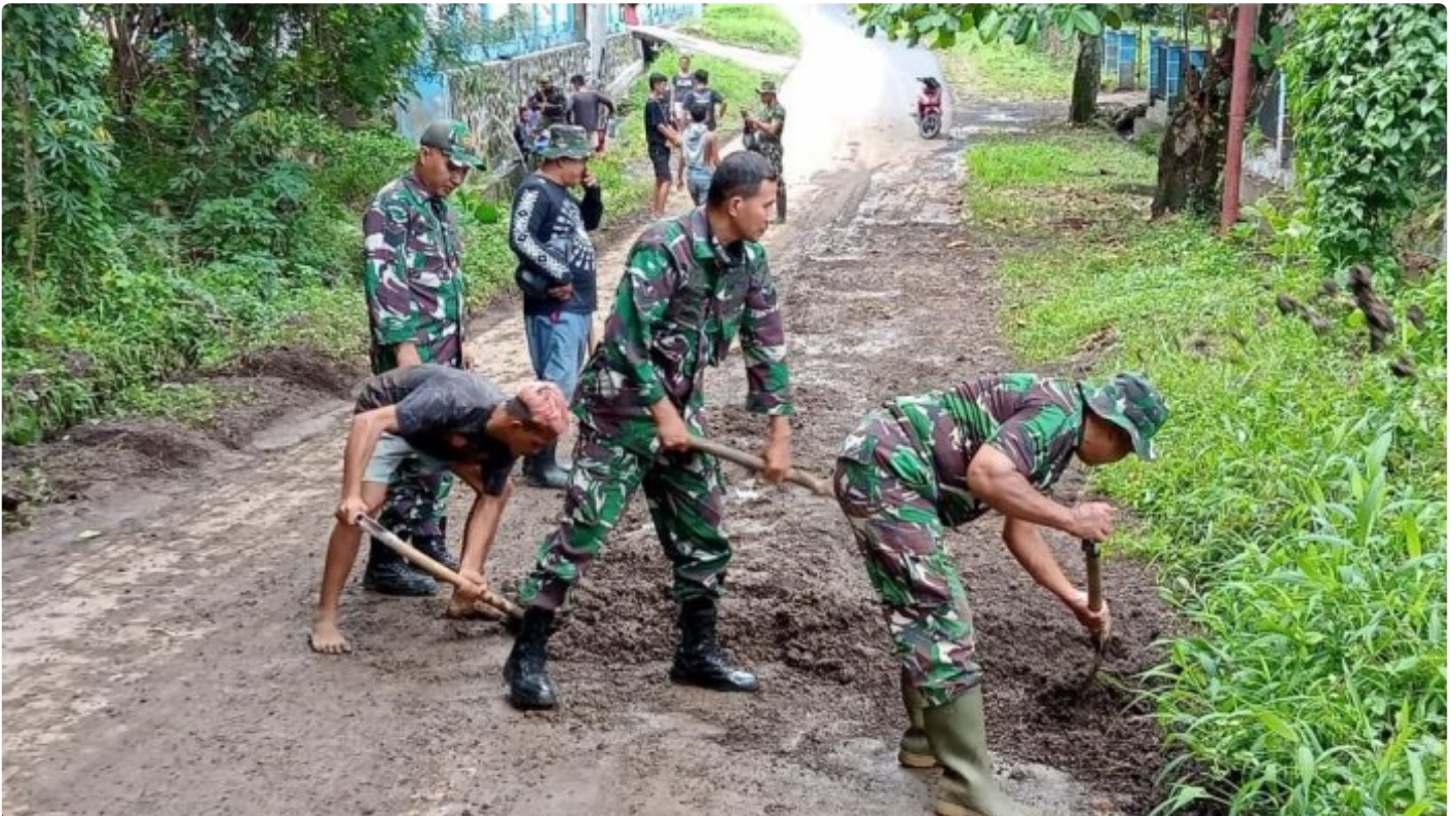
Personil Kodim 1310/Bitung kerja Bhakti bersihkan tanah longsor tutupi akses Jalan
